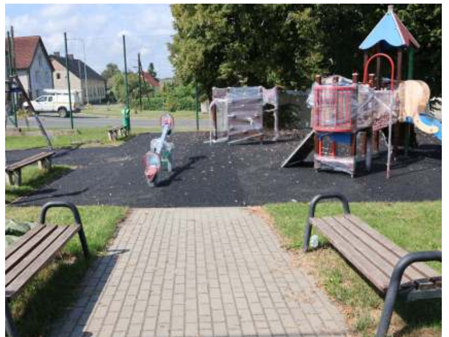
Wyremontowano nawierzchnię placu zabaw przy SP w Kaławie.
